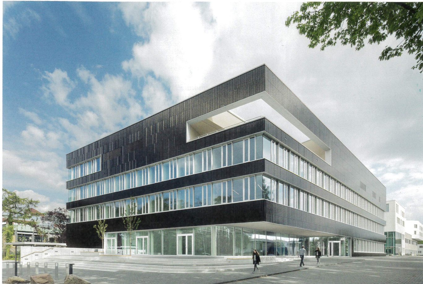
Bild 1. Der Neubau HARBOR befindet sich im Zentrum der neuen Science City West in Hamburg
