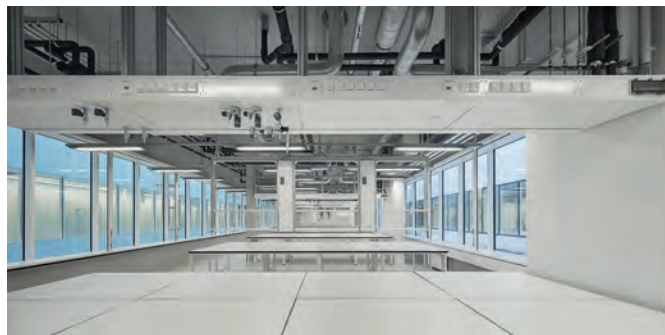
Bild 6. Das Großraumlabor für interdisziplinäre Forschung im 1. OG wird von zwei Seiten belichtet; da höchste Flexibilität bei der Nutzung des Raumes in verschiedenen Konstellationen angestrebt wurde, konzentrieren sich die Mediensäulen auf wenige Punkte
