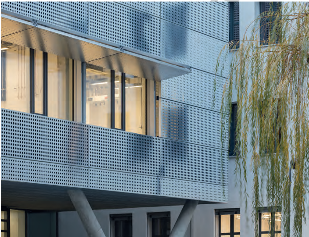
Bild 8. Fassade aus gelochten Metallpaneelen (Fotos 1, 4–8: Werner Huthmacher)
