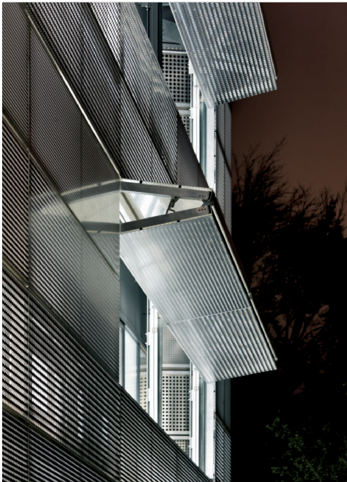
Bewegliche Fassadenelemente zur Verschattung sind eines der Markenzeichen des Büros Nickl & Partner.
