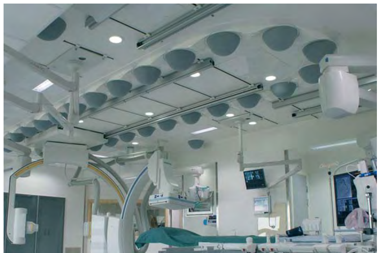
Abb. 32: Temperaturkontrollierter Airflow –Hybrid-OPs mit TAF
