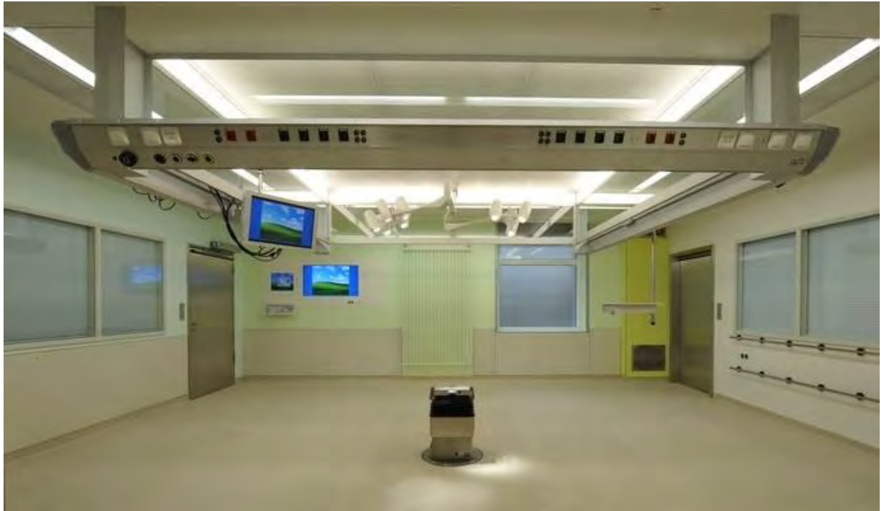
Abb. 30: Differentialflow mit Strömungsschürze und 3-seitigem Medienbalken
